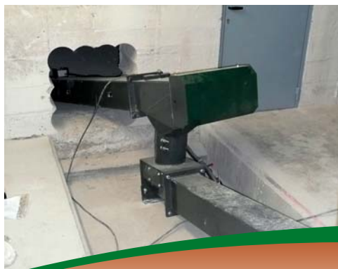
La vis sans fin emmenant les plaquettes hors du silo à la chaufferie
